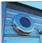
ソーラー換気扇取付
