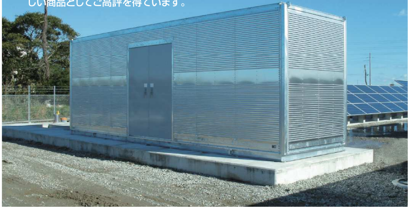
写真提供：株式会社トーケ三様 太陽光発電設備用パッケージ（サイズ：L 8,199×W 2,331×H 2,960mm）
